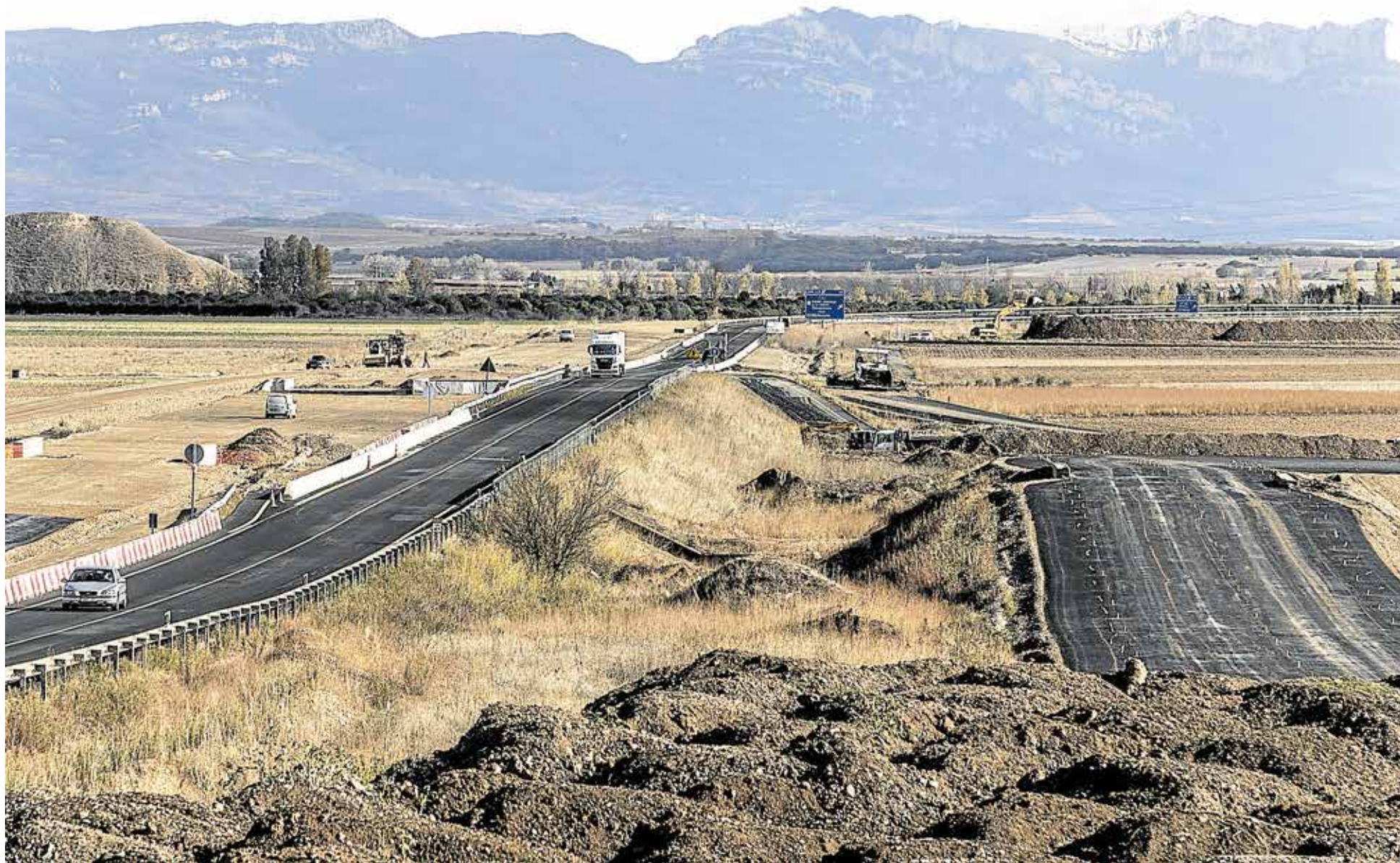
Imagen de archivo de las obras de la A-12 o autovía del camino, a la altura de Grañón, el único tramo pendiente en territorio riojano. JUSTO RODRÍGUEZ
