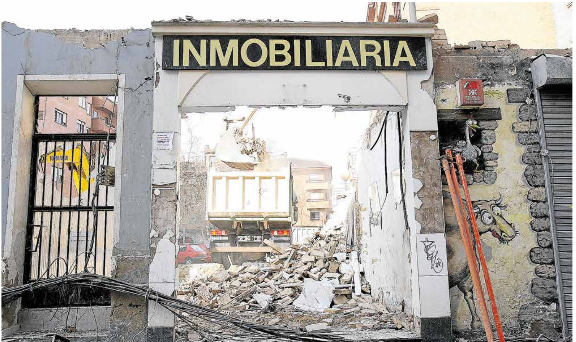
Simbólico derribo en la calle Lardero de Logroño en 2009, cuando los comienzos del estallido inmobiliario ya se hacían sentir. JUAN MARÍN
