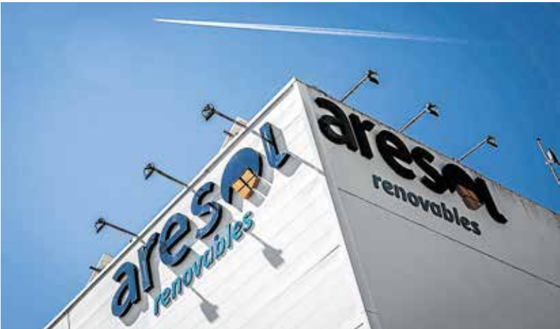
Instalaciones de Aresol. J. RODRÍGUEZ
