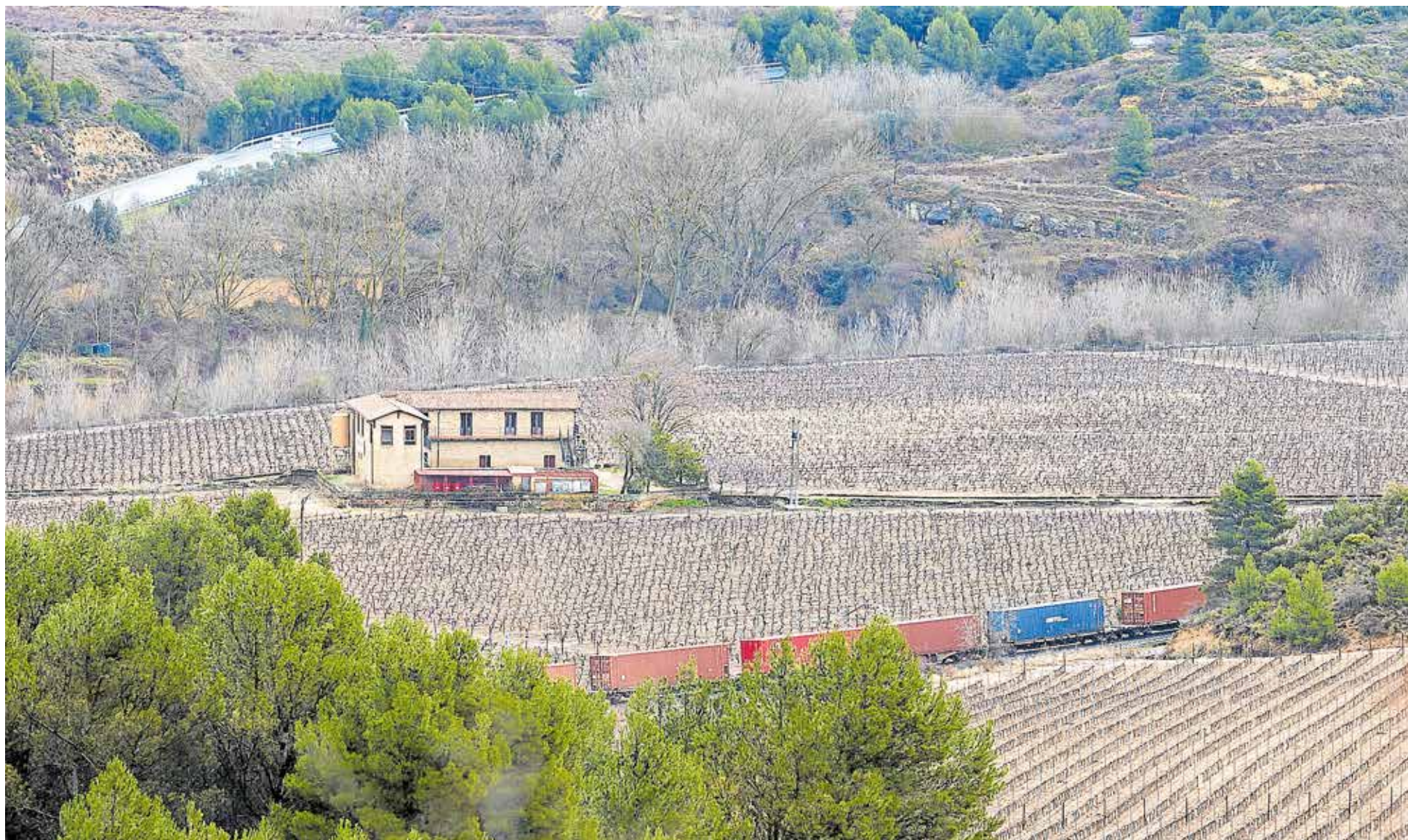
Las necesidades en infraestructuras ferroviarias, viarias y los retos del sector vitivinícola marcarán el futuro a medio y largo plazo de La Rioja. SONIA TERCERO
