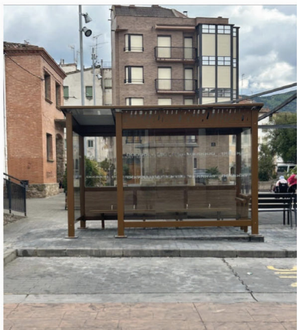
Marquesina de autobús Nalda
