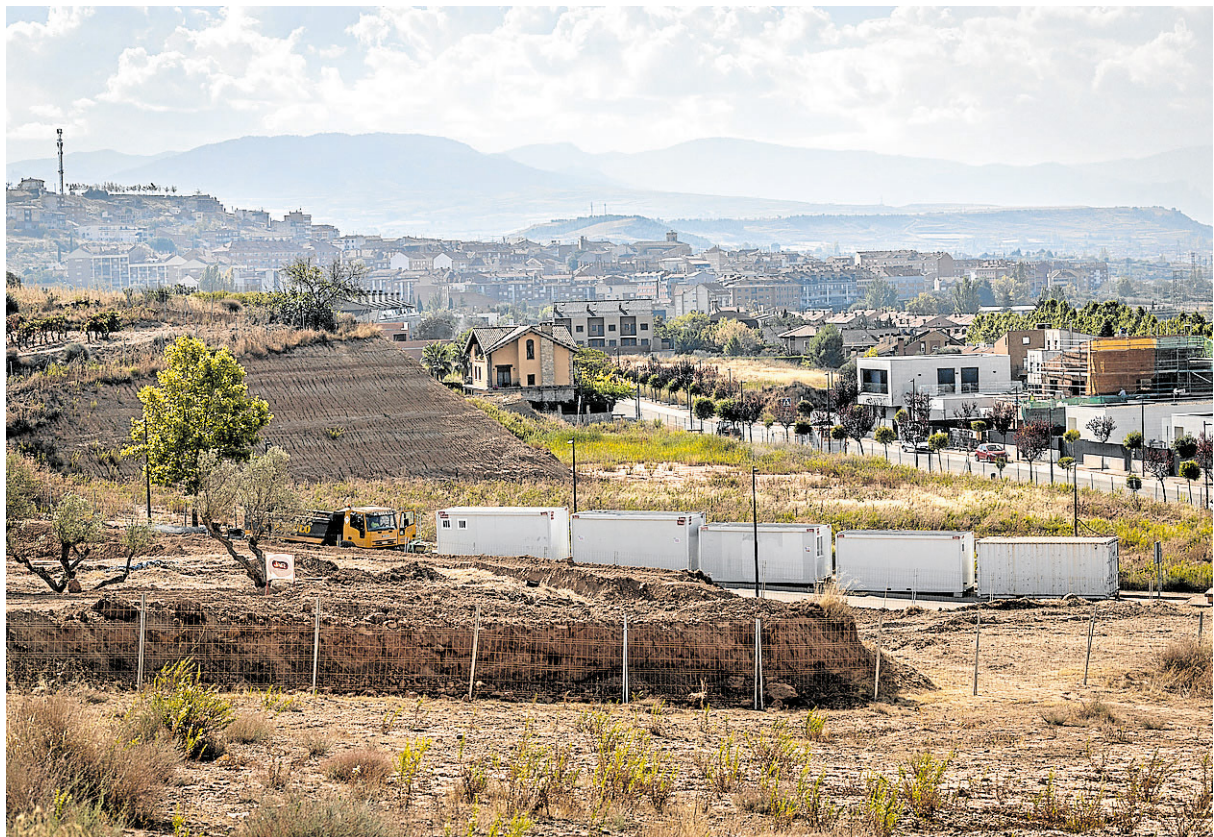
En primer término, las obras de construcción del cuartel de la Guardia Civil, con Villamediana de fondo. J.R.
