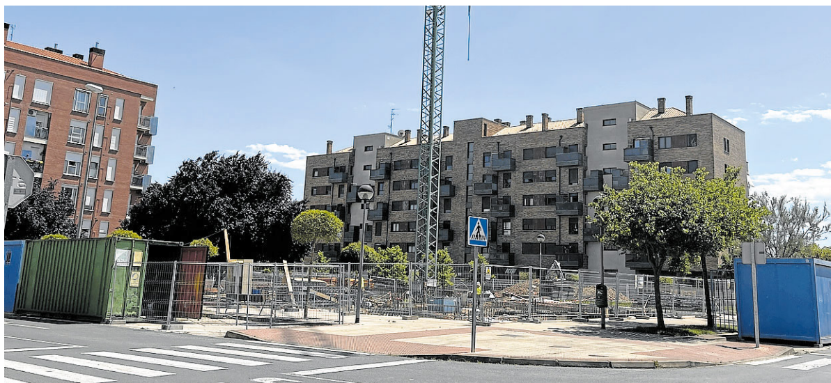
Construcción de viviendas protegidas en la capital riojana. A.L.
