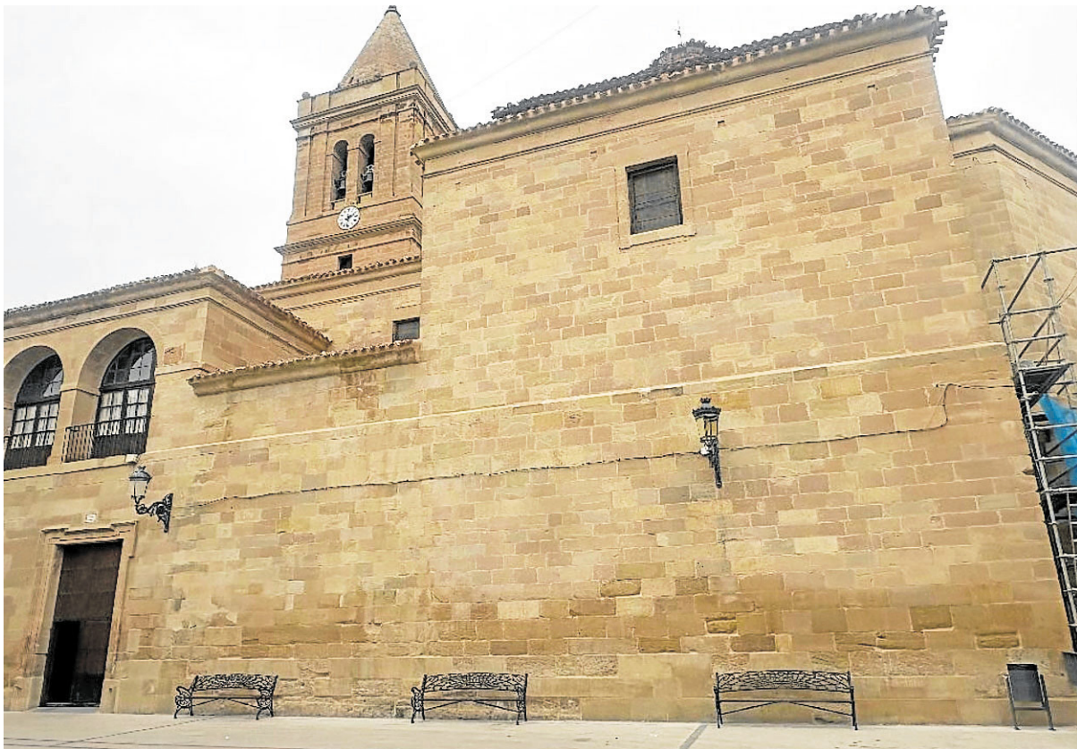
Iglesia parroquial de San Martín, donde se está actuando en la fachada este. AYUNTAMIENTO DE ALBERITE
