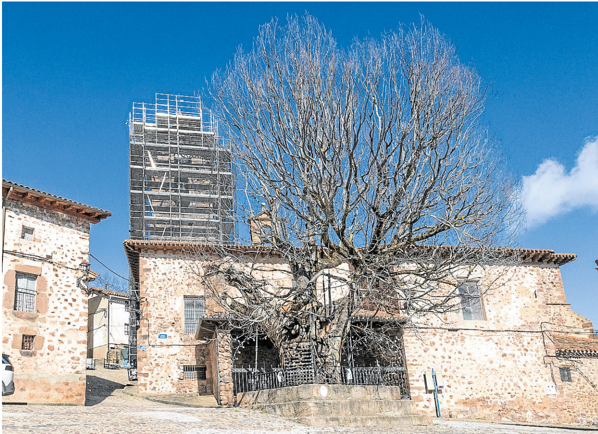
La torre de la iglesia se ha beneficiado de una rehabilitación integral. L.R.
